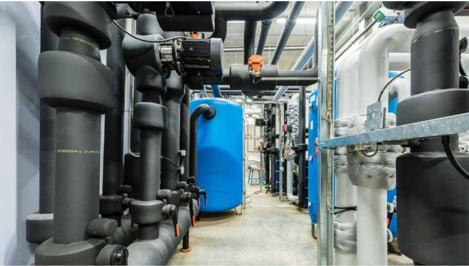
De technische ruimte van IKEA Zwolle waar de warmtepomp staat en waar de warmte of koude via het leidingnetwerk getransporteerd wordt naar de vloerverwarming.
