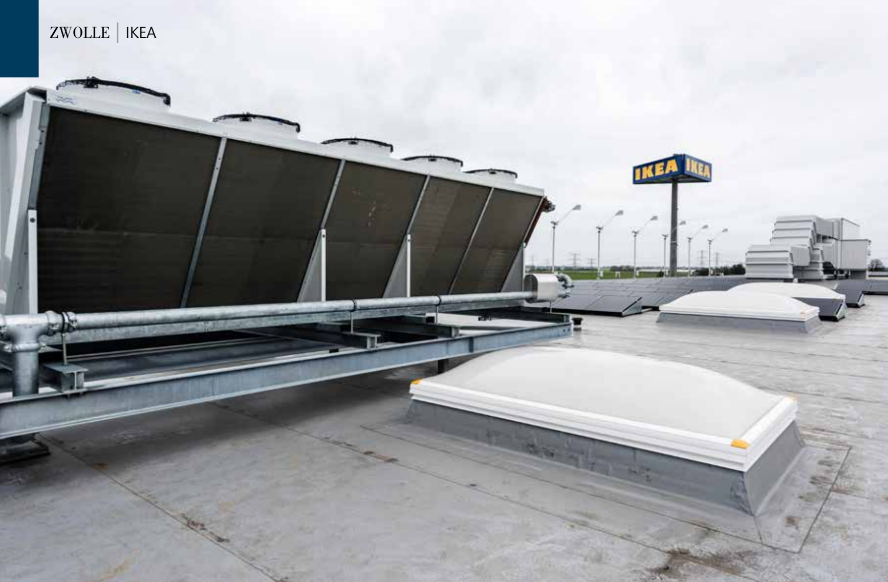
Op het dak staan de luchtbehandelingkasten die voorzien zijn van warmteterugwinning uit de afgezogen ruimtelucht.
